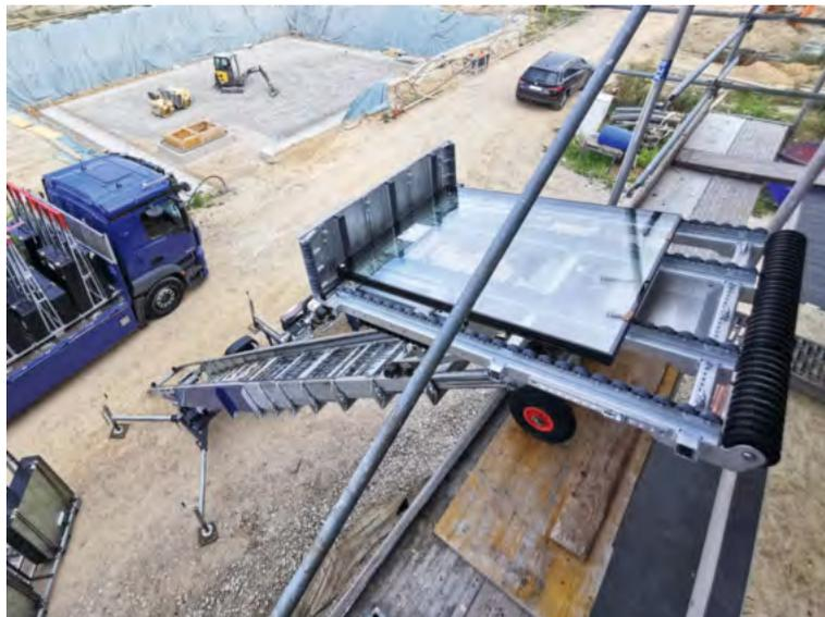
Die kippbare Pritsche des Aufzugs ermöglicht die komfortable Entnahme der Fenster.
