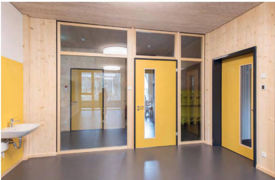
Sowohl Umfassungs- als auch Profilzargen in Kombination mit Massivholz zargen sowie umlaufende Festverglasungen aus Holzrahmenprofilen gehören zu den schützenden Türlösungen.
