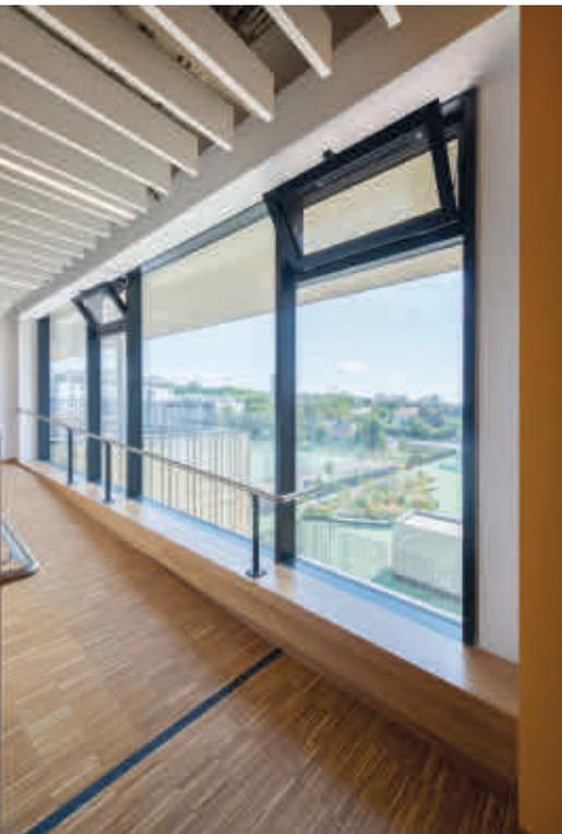
*Geze-Slimchain-Kettenantriebe ermöglichen das automatische Öffnen und Schließen der Fenster.*
